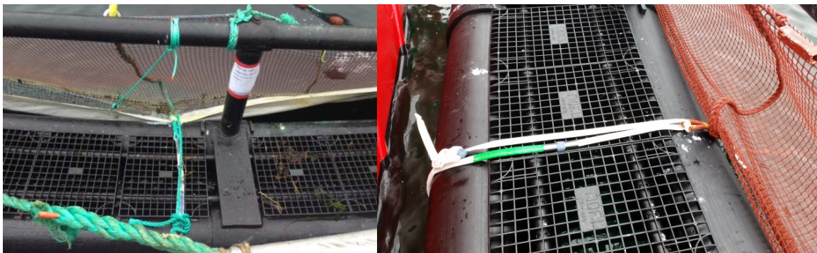
Figur 17: Lerøy Aurora har to løsninger for innfesting hvor klammer ikke harmoniserer med innfesting til notpose (Foto:venstre SINTEF, høyre Løvold AS)
