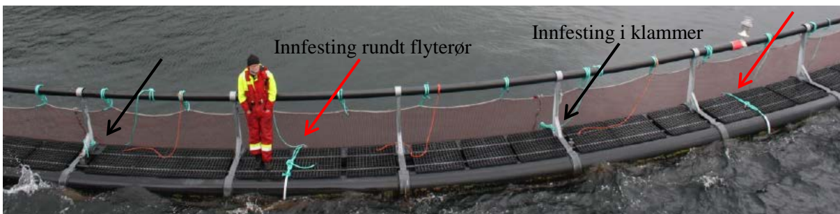
Figur 14: Forskjellige type innfestingsløsninger på en og samme flytekrage (M. Høiseth, SINTEF Fiskeri og havbruk)
