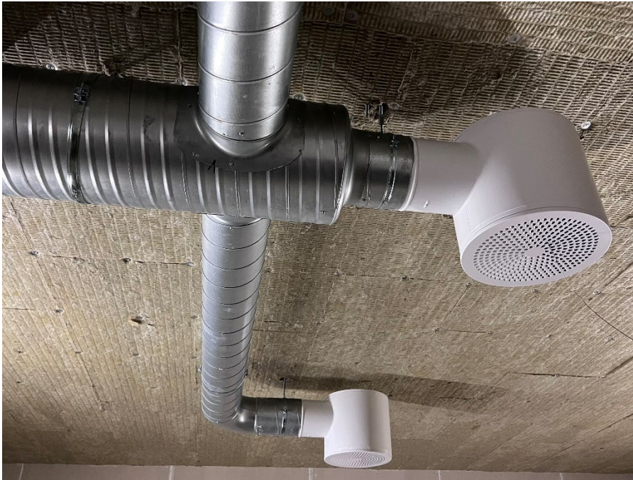
Figur 2-4: Ventilasjonskanaler montert hengende fra taket.
