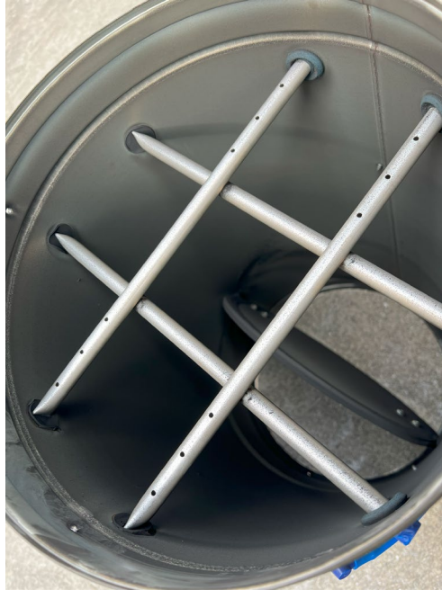
Figur 4-22: Avtrekksspjeld etter test 12.
