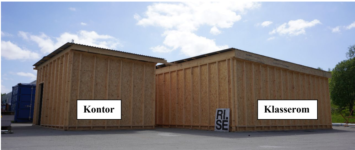
Figur 2-1: Bilde av testbygning utvendig. Kontoret vises til venstre og klasserommet vises til høyre. Døra til venstre går inn i korridoren som ligger i bakkant på bildet. Foto: RISE Fire Research.
