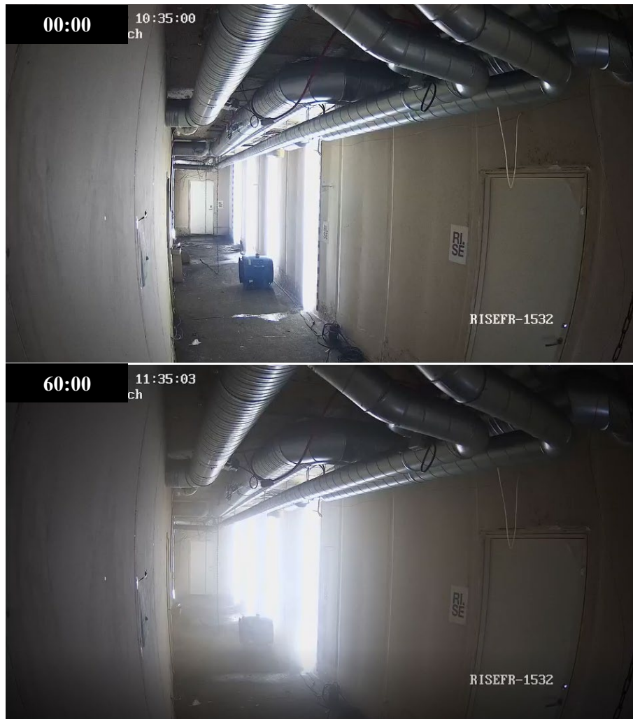
Figur 4-91: Bilde fra korridoren ved start av test 14 (øvre) og etter en time (nedre). Tid (mm:ss) etter teststart.
