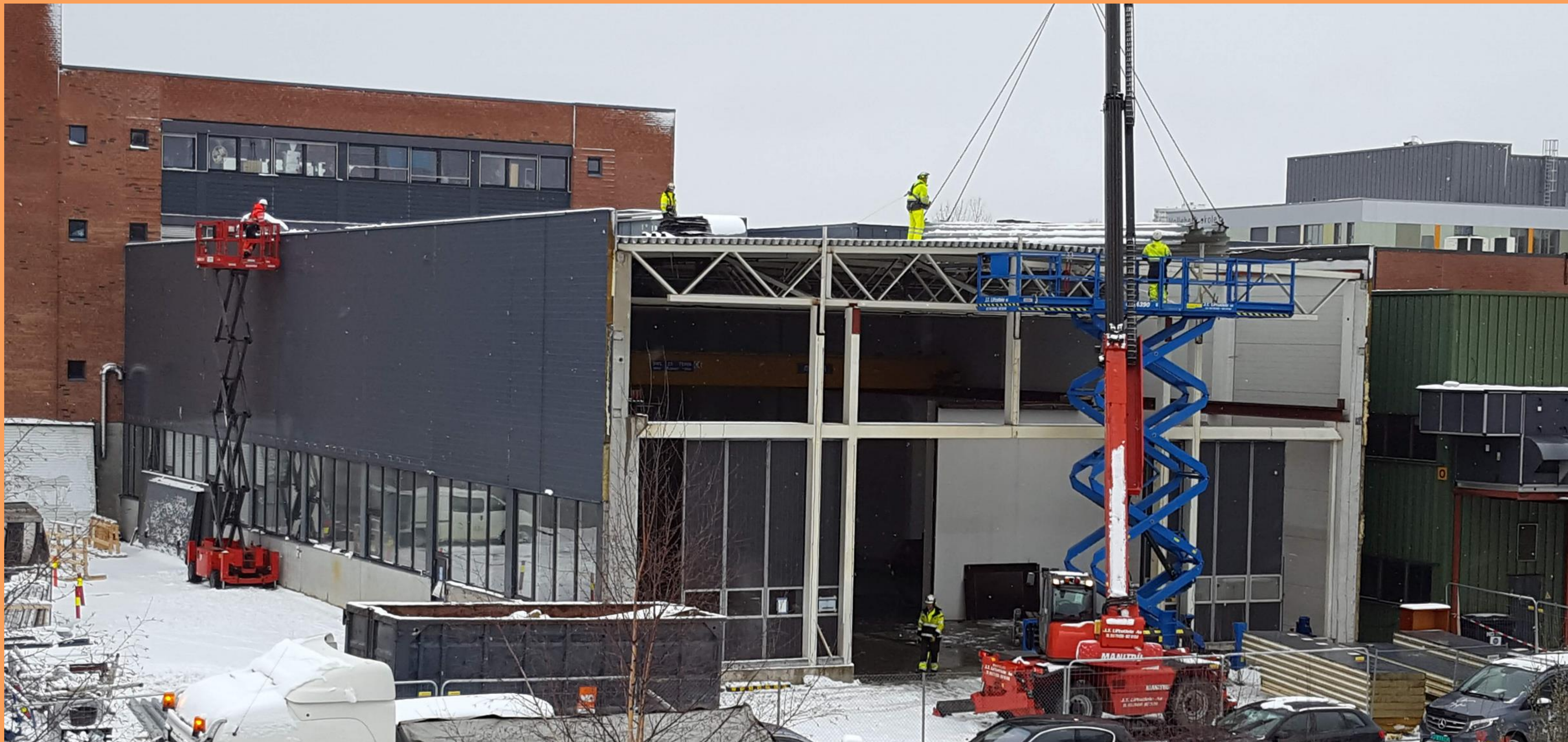
Lagerhall/verksted på Vollebekk i Oslo Demontering for flytting OBOS, Midtstøl, Resirqel
