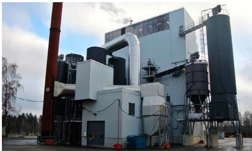
Figure 20: The Jordbro power plant. Photo: Vattenfall
