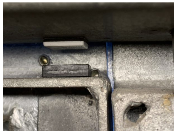
Figur 2.1: Eksempelvis montasje av magnetsensorer
