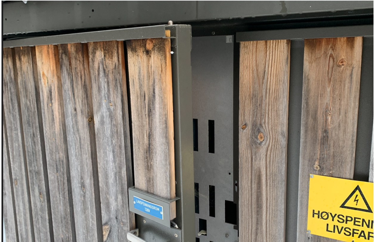
Figur 2.2: Eksempelvis montasje av proximity dørsensor
