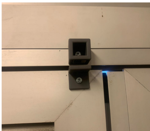
Figur 2.1: Eksempelvis montasje av magnetsensorer
