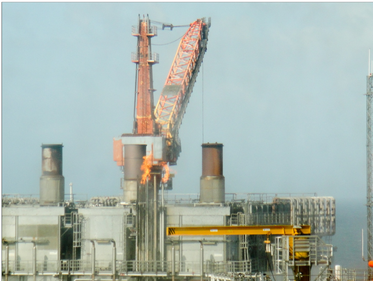
Figur 3 Brannen i avluftingsrørene sett fra PH-innretningen kl. 17.10
