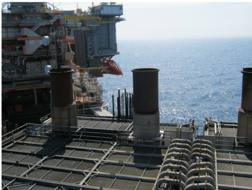
Figur 13 Turbineksosen er plassert på vindsiden av avluftingsrørene. Bildet er tatt fra PCP-kranen.
