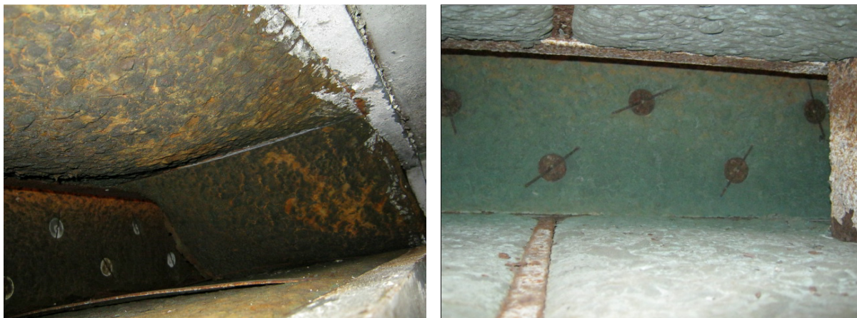
Figur 15 Utluftkanal fra maskinrom på PCP (til venstre). Utluftkanal fra tilsvarende maskinrom på QP (til høyre).
