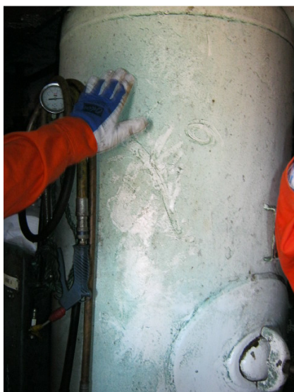
Figur 14 Spor etter ukjent væske på startlufttank inne i motorrommet.
