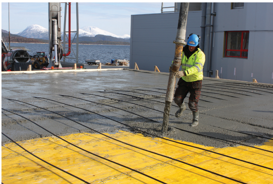
Støping av fiberarmert etterspent dekke i Spjelkavik. Foto: Steinar Trygstad, Thilt AS
