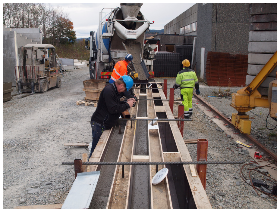
Støpeformene på betongfabrikken Contiga i Stjørdal. Foto: Gunrid Kjellmark
