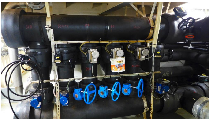
Figur 6. Styring av sirkulasjonspumper i seksjon 3 med de tre største tankene på 300 m 3
