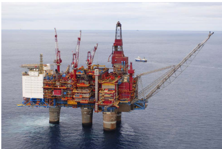
Figur 3.4 Gullfaks C-plattformen (Foto: Øyvind Hagen/ Statoil).
